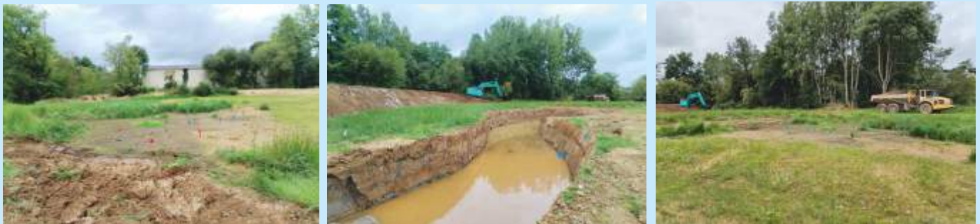
Photos du site des anciennes lagunes
