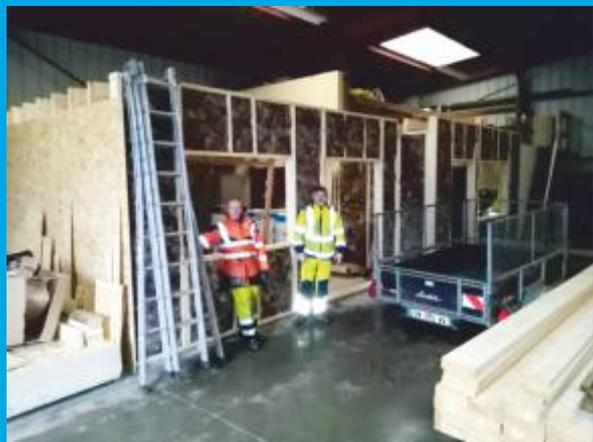
**Une rénovation des ateliers municipaux est en cours de réalisation afin de créer une pièce d'environ 40m2 chauffée et isolée thermiquement.**
