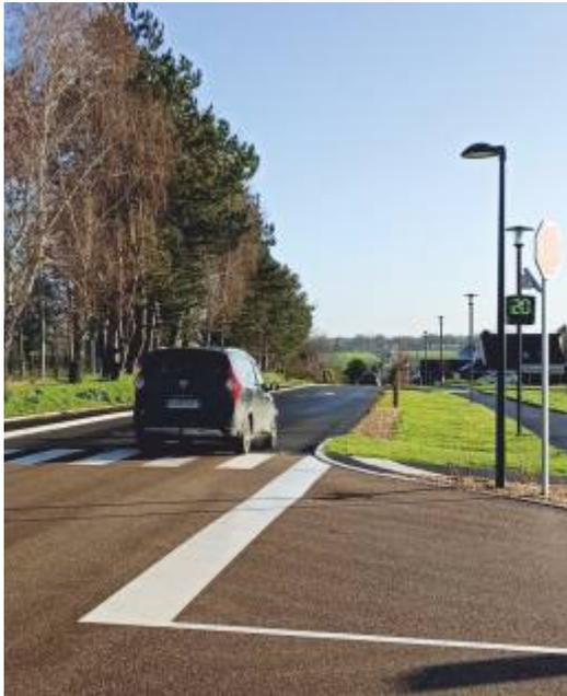
D'une largeur initiale de 6,20 mètres, la chaussée a été réduite à 5,50 mètres et agrémentée d'un nouveau trottoir et d'un aménagement paysager. Le plateau, les multiples rétrécissements, l'écluse et les séparateurs invitent à réduire la vitesse à 30 km/h. Des éclairages publics ont été ajoutés au niveau des passages piétons.
